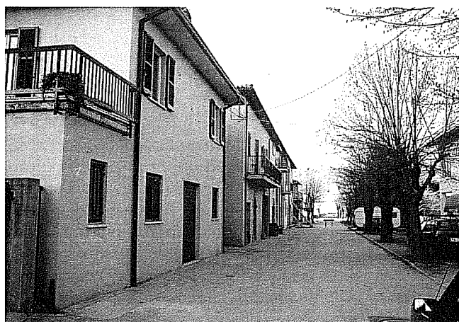
Foto 20-21-22. Sellano centro storico. Edificio privato recentemente ben ristrutturato (utilizzando anche intonaci armati) e rimasto assolutamente indenne.
