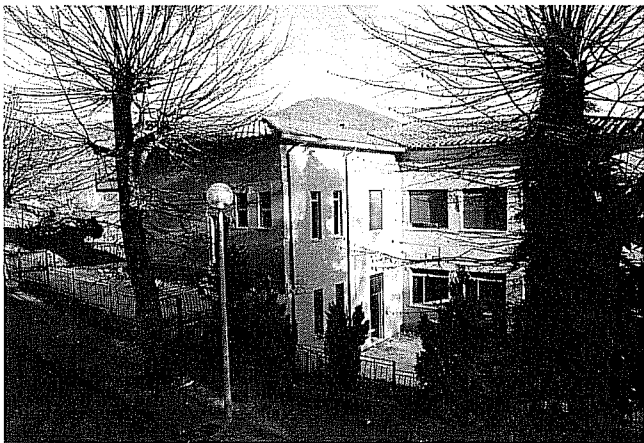
Foto 06-07. Sellano centro storico. Edificio scolastico già ristrutturato, ma molto lesionato per scarsa resistenza delle strutture in elevazione.
