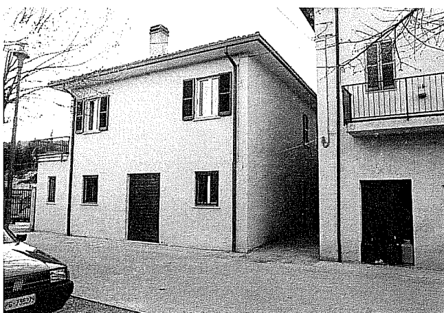
Foto 20-21-22. Sellano centro storico. Edificio privato recentemente ben ristrutturato (utilizzando anche intonaci armati) e rimasto assolutamente indenne.
