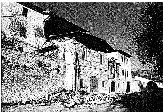
Foto 08. Sellano centro storico. Edificio di civile abitazione già ristrutturato, ma molto lesionato per scarsa resistenza delle strutture in elevazione. Il tetto in primo piano era posizionato un piano più in alto; da notare la particolare inconsistenza delle murature che si sono letteralmente sbriciolate.
